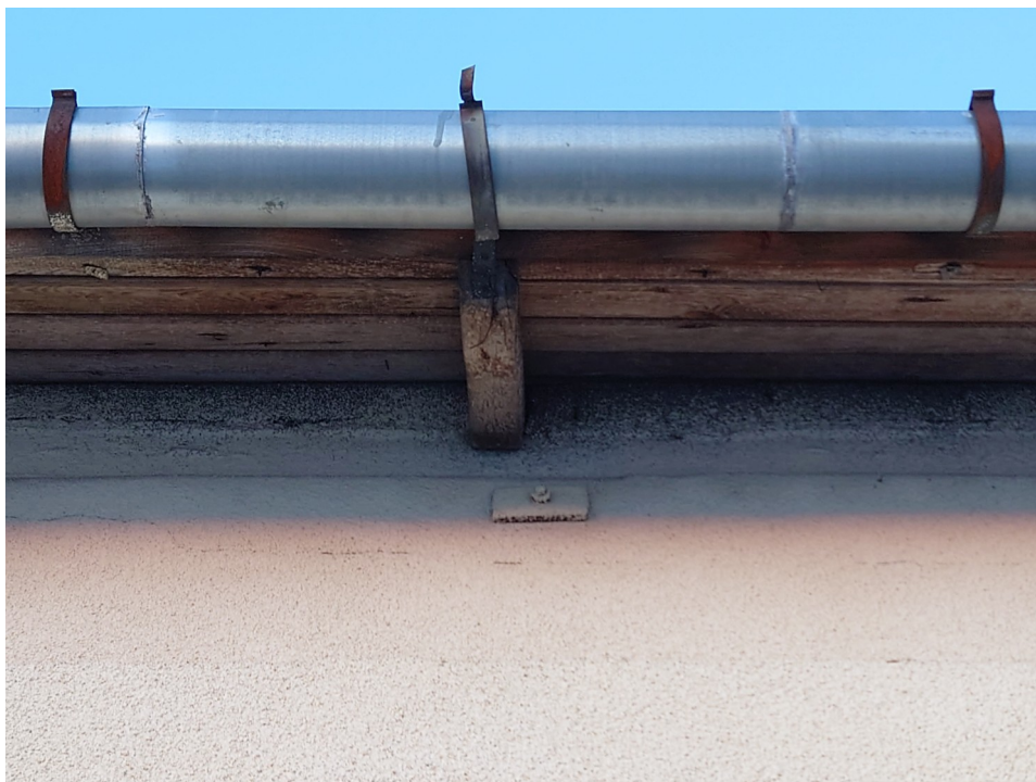
Fot.5 Wzmocnienia konstrukcji ścian i stropu śrubami ściągającymi
