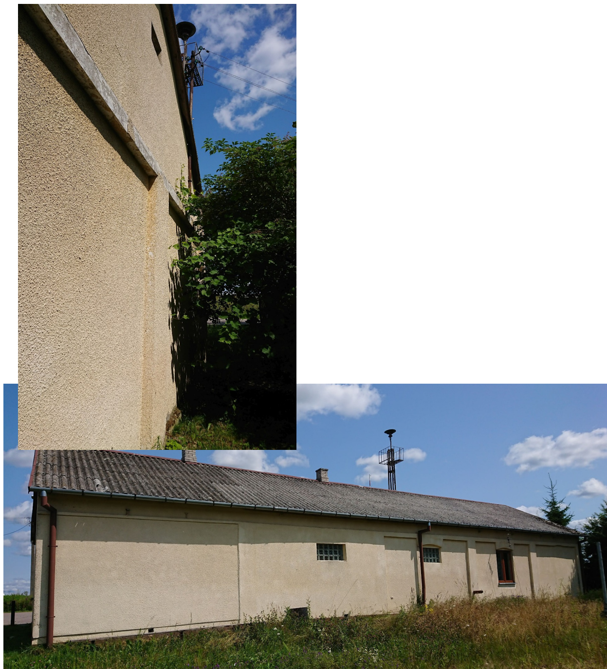
Fot.4 Wzmocniona ściana zewnętrzna od strony wschodniej
